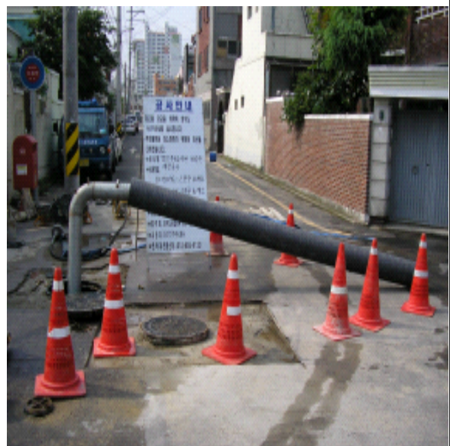
관세척 퇴수구 설치(종점)
