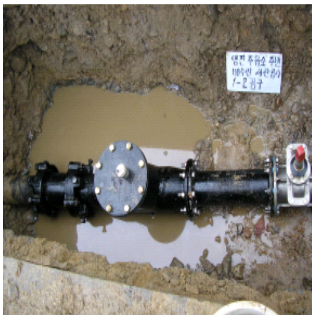
관세척 청소구 설치(시점)
